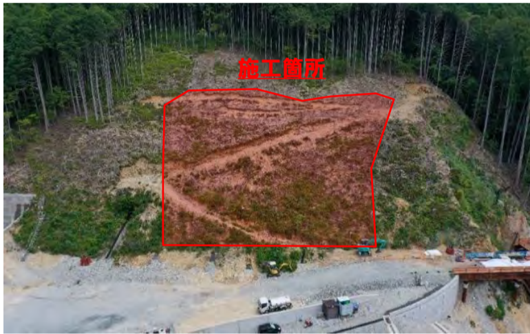
工事箇所全景
