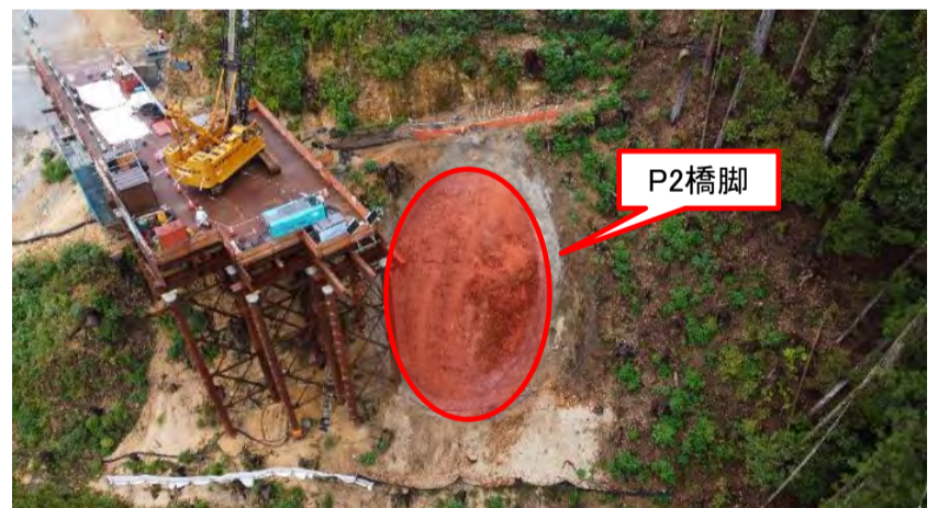
工事箇所全景
