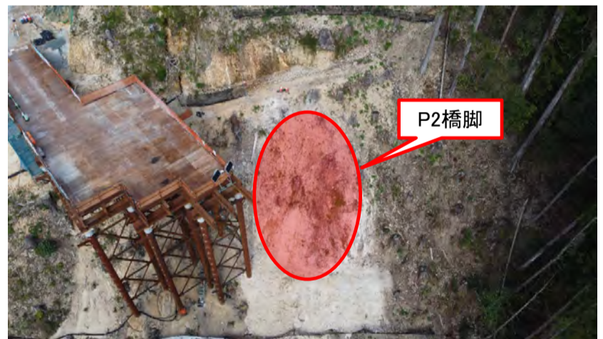
工事箇所全景
