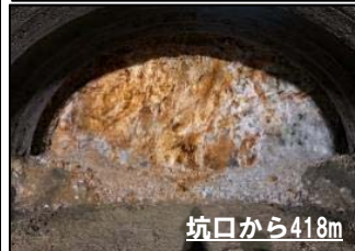
鋼製支保工建込み
