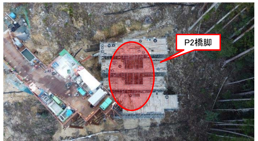
工事箇所全景
