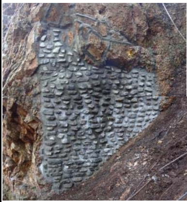
地山補強 岩接着工
