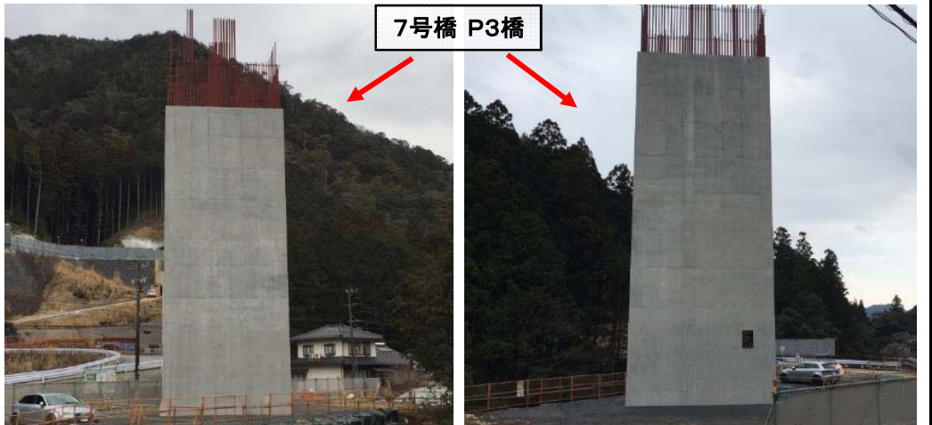
工事箇所全景
