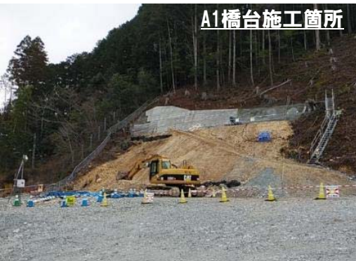
工事箇所全景
