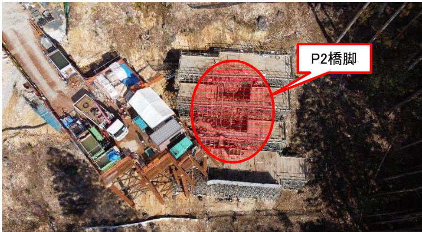
工事箇所全景
