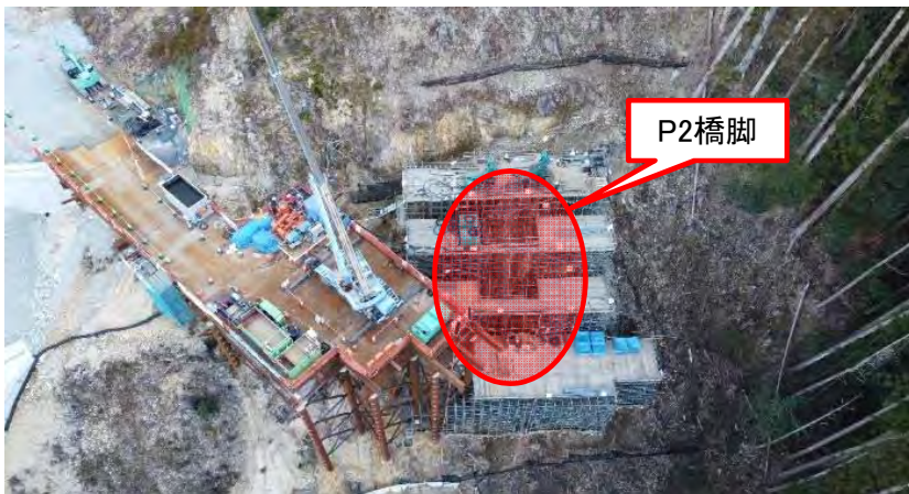
工事箇所全景
