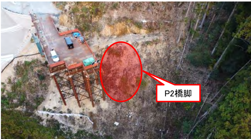
工事箇所全景
