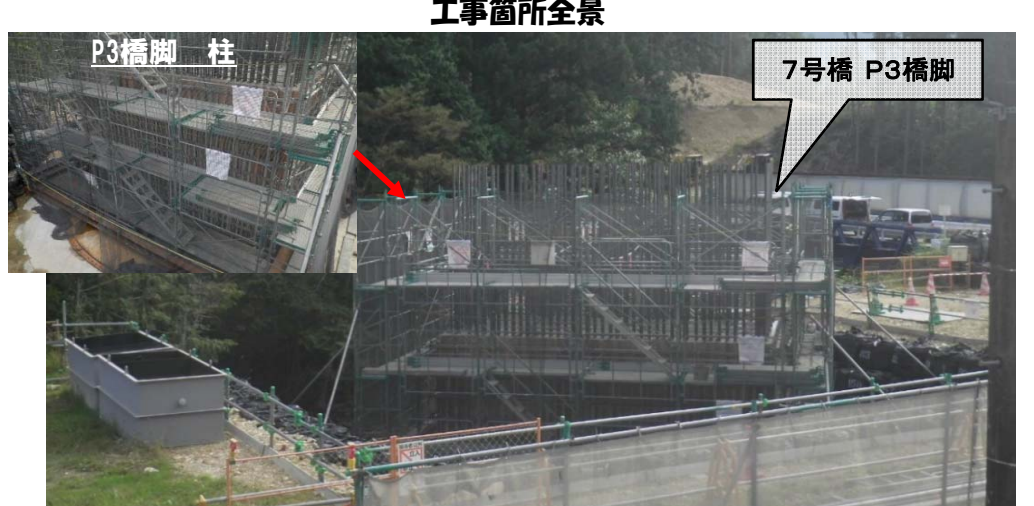
工事箇所全景
