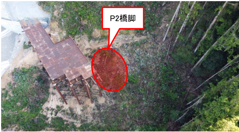
工事箇所全景
