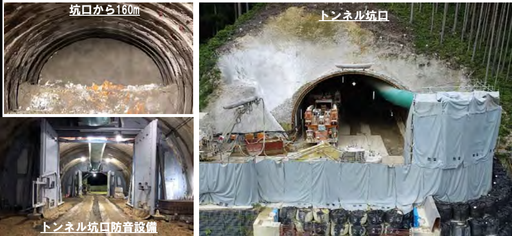
工事箇所全景
