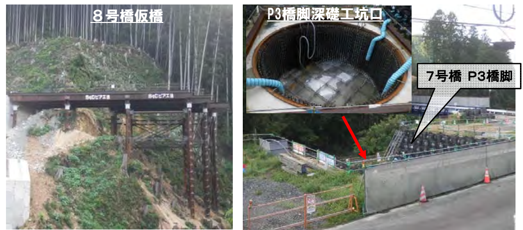
工事箇所全景
