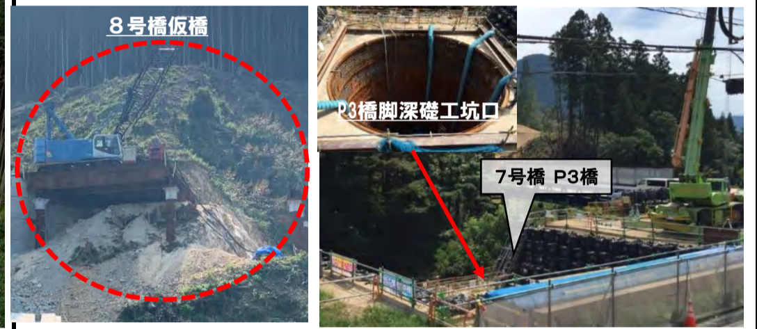
工事箇所全景
