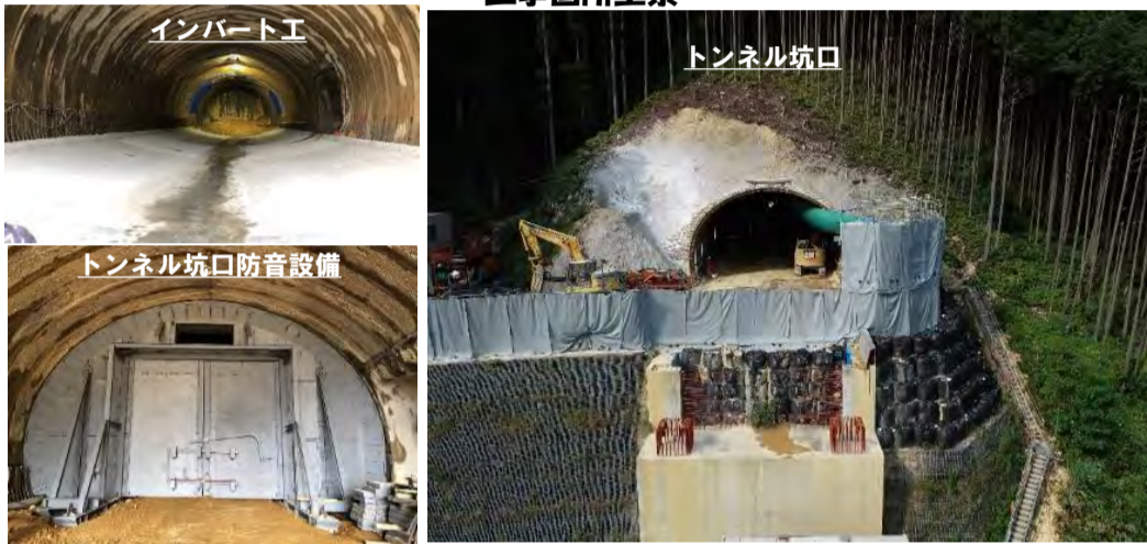
工事箇所全景
