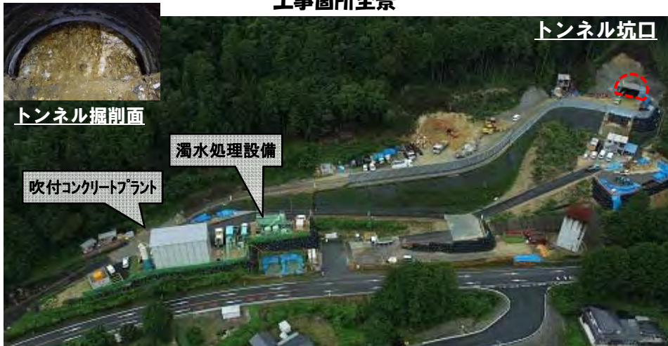
工事箇所全景
