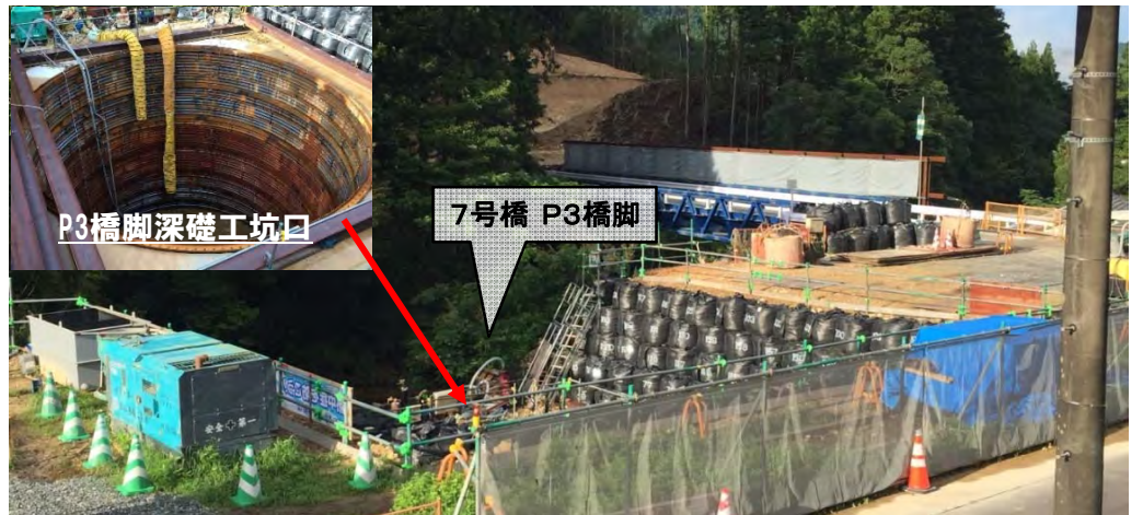
工事箇所全景
