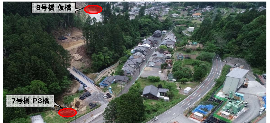
工事箇所全景
