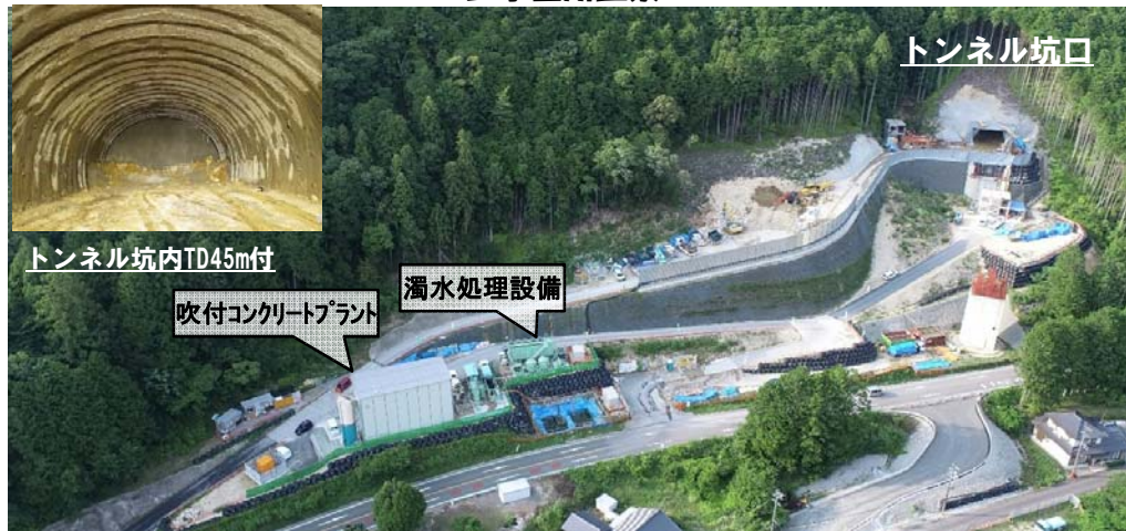
工事箇所全景
