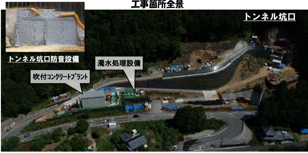
工事箇所全景
