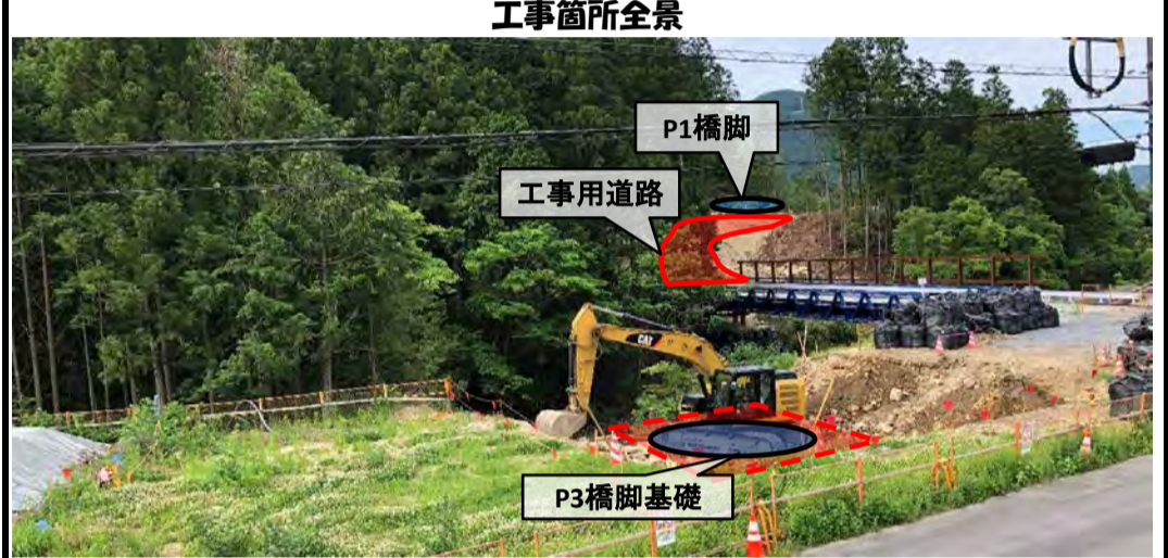
工事箇所全景
