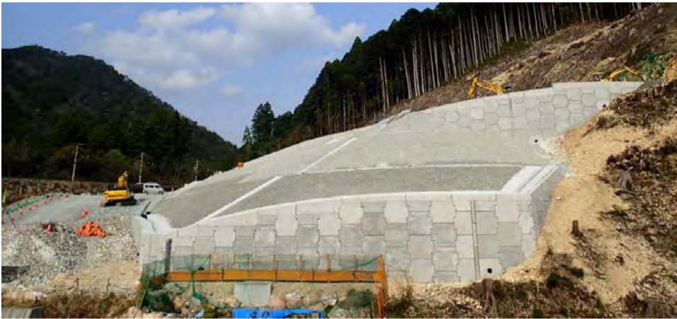
工事箇所全景
