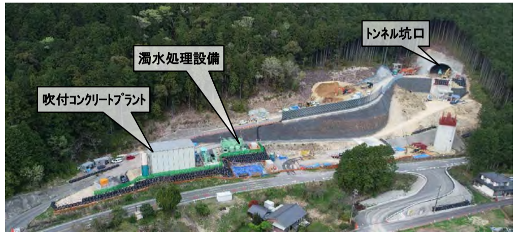
工事箇所全景
