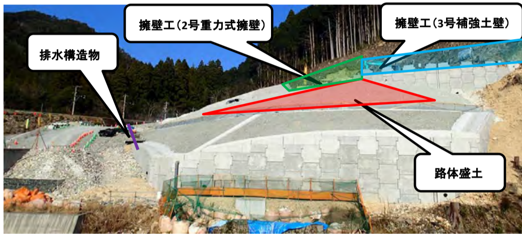
工事箇所全景
