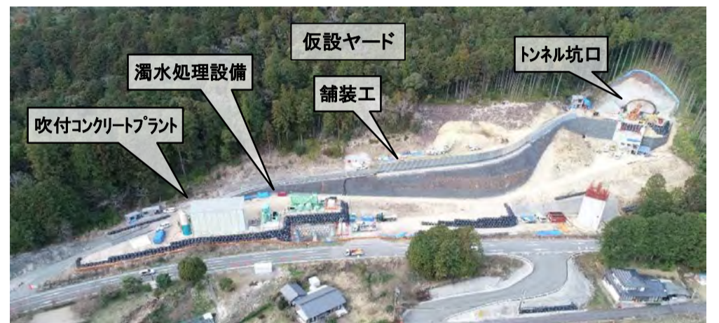
工事箇所全景
