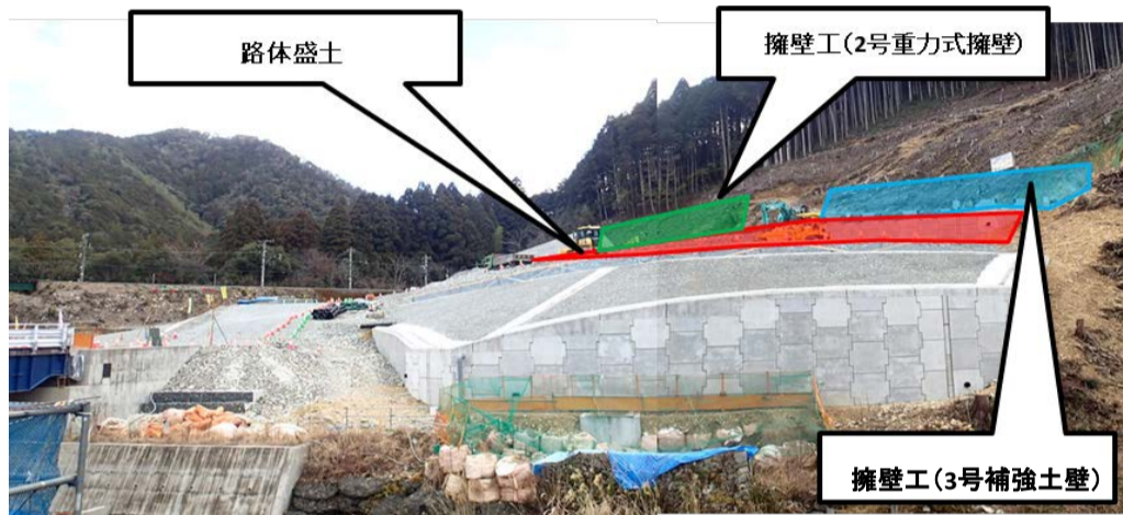
工事箇所全景
