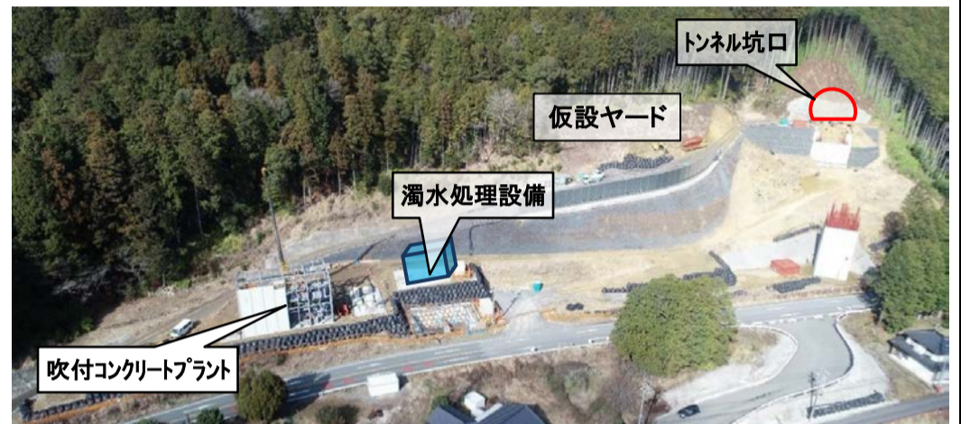
工事箇所全景
