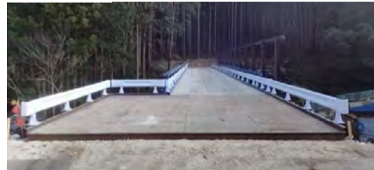
仮橋 施工箇所
