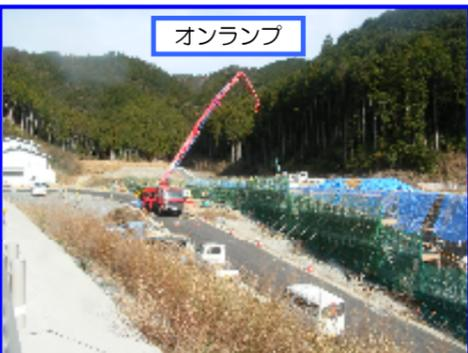
コンクリートの擁壁（最大高さH=4.0m）を築造しております。
