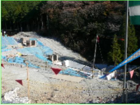
現在、最下流部の河川の改修及び落差工上部の縦排水工を施工中です。
