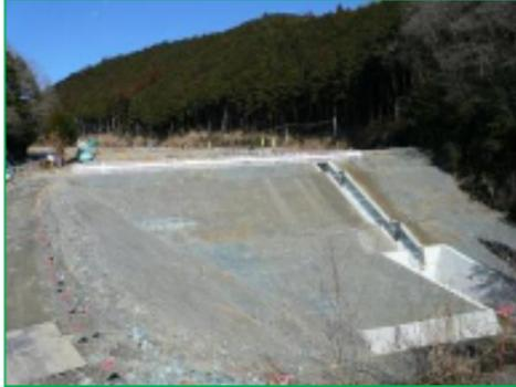
下流構造物が完了し法面整形を完了させ、これから植生及び場内道路舗装を行って行きます。
