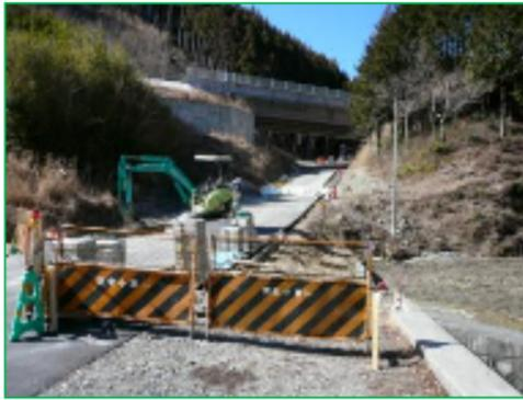
排水構造物がほぼ完了し、舗装復旧を行って完了となります。
