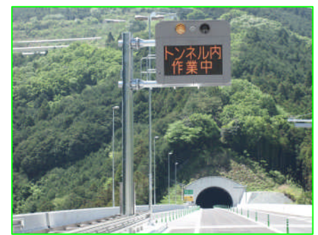
別所トンネル警報表示板 No.211 付近より終点を望む
