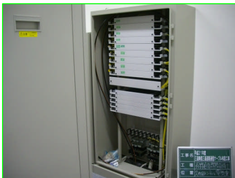
三遠トンネル主電気室光成端箱
