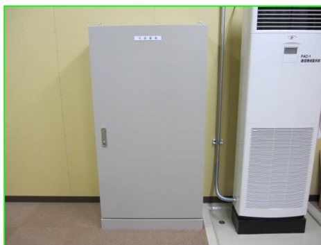
三遠トンネル副電気室光成端箱
