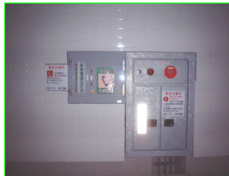
トンネル内非常警報設備
