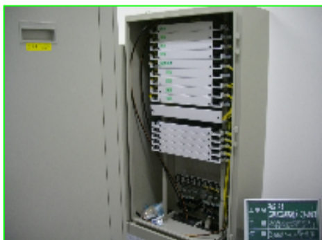
三遠トンネル主電気室光成端箱
