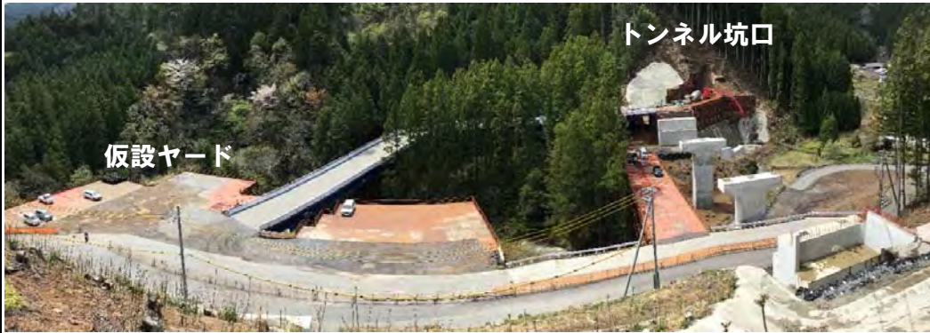
工事箇所全景(坑口対岸より望む)
