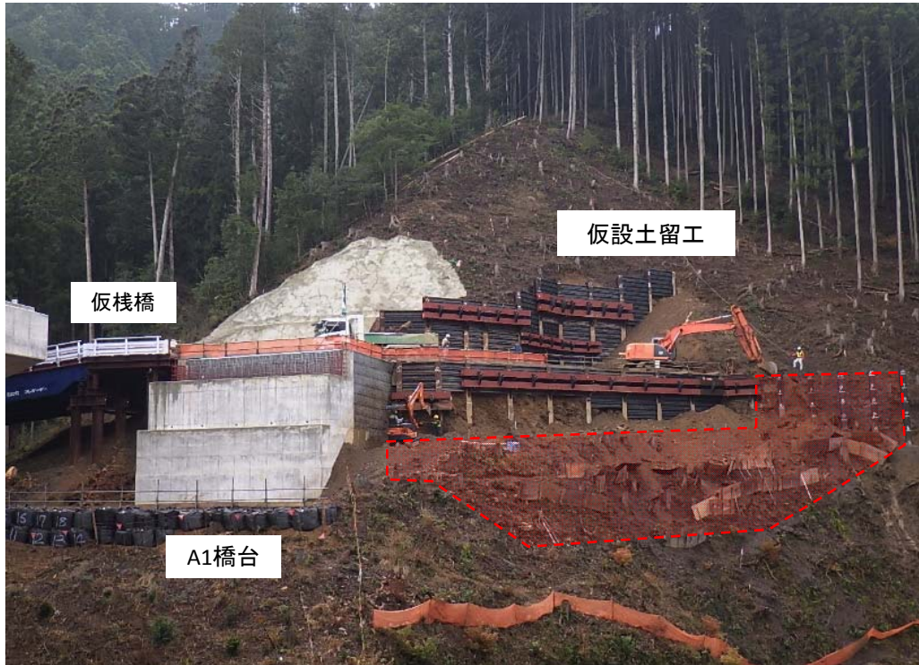
下段部仮設土留工
