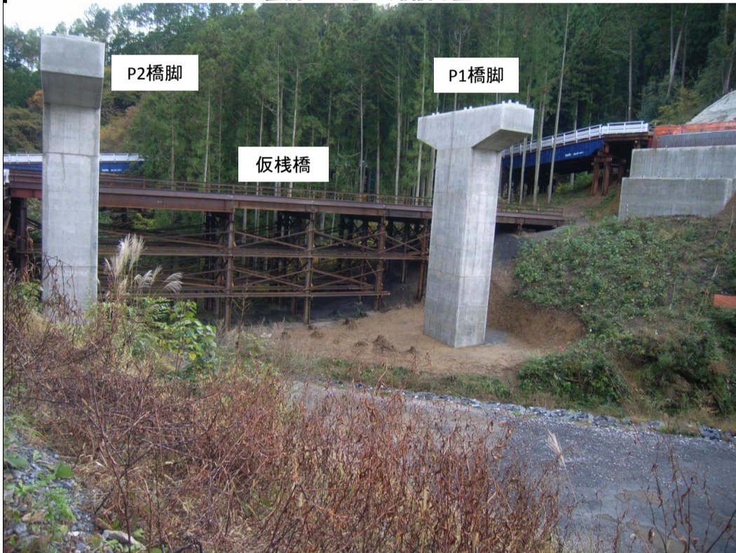
上流からP2・P1橋脚を望む
