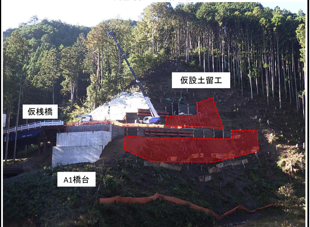
A2橋台側よりA1橋台を望む
