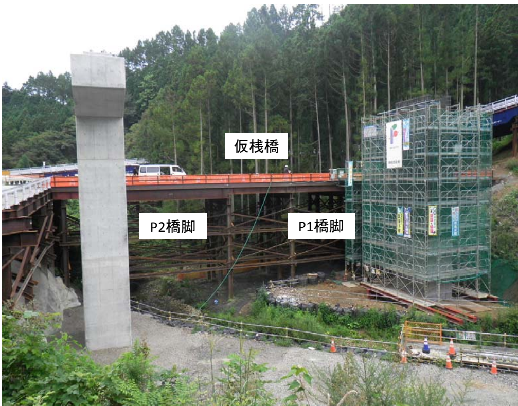
上流からP1・P2橋脚を望む
