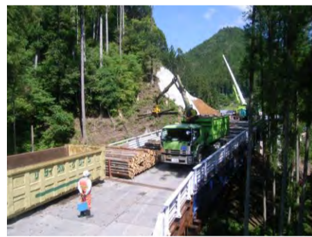
←伐採作業状況(仮栈橋上)
