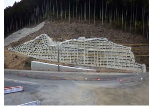
法面工・軽量盛土工
