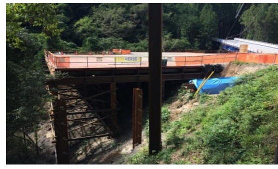
仮設構台③の様子
