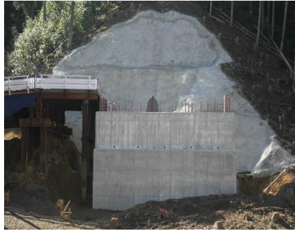
A1橋台(躯体完了)
