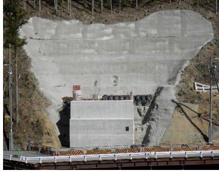
A2橋台(躯体完了)
