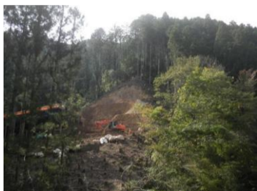
A1橋台(躯体作業準備中)
