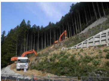
A2橋台(床堀・残土搬出作業中)
