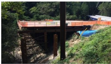
仮設構台③の様子
