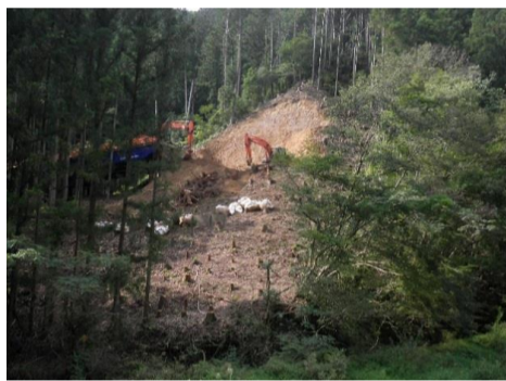
A1橋台床堀・残土搬出作業中
