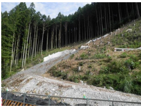
A2橋台崩落部追加伐採完了
