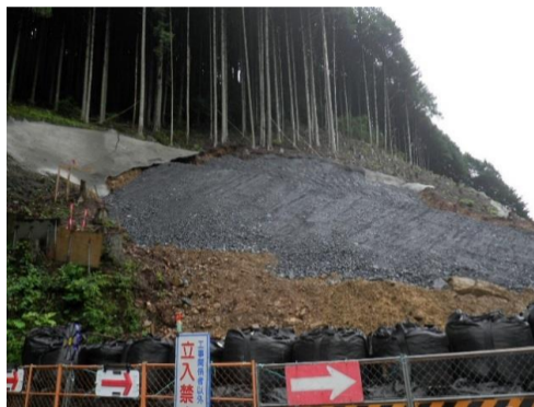
A2橋台崩落部の法面对策検討中
