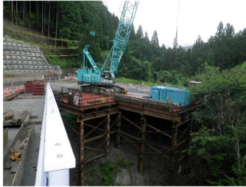
トンネル用仮設構台完了
