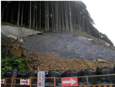
A2橋台崩落部の法面对策検討中
