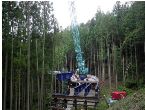
3号TN工事用道路(仮橋・仮栈橋施工中)
