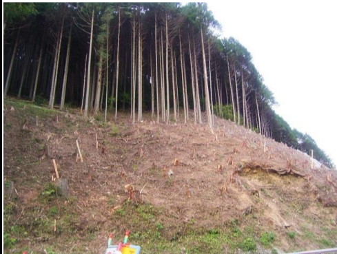
A2橋台施工箇所(伐採完了)
