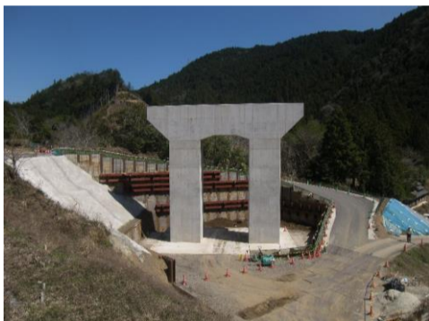
P2橋脚施工箇所(南→北)
