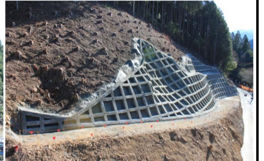
施工箇所(起点側から撮影)
