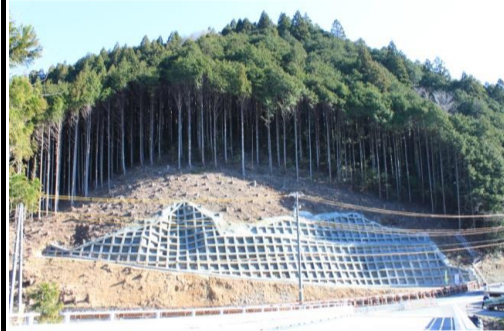
施工箇所(3号TN側から撮影)
