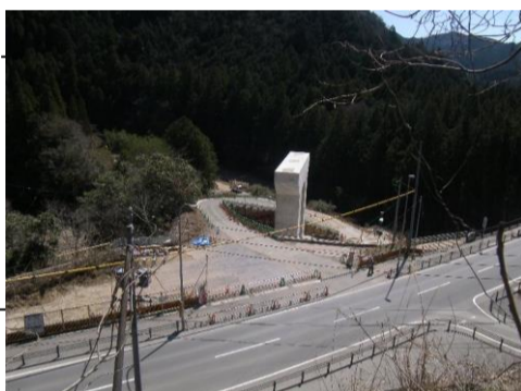
P2橋脚施工箇所(西→東)
