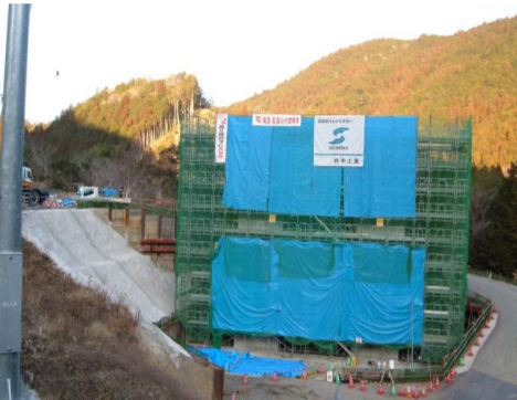
P2橋脚施工箇所(南→北)
