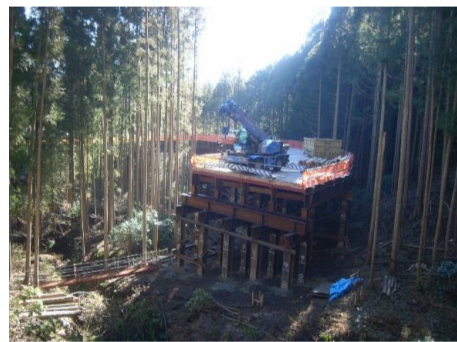
施工箇所(起点側から撮影)
