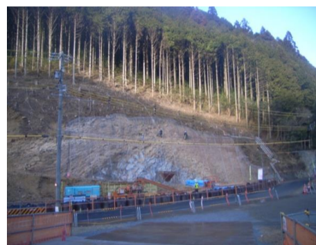
施工箇所(3号TN側から撮影)
