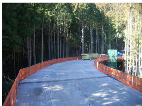
施工箇所(町道から撮影)
