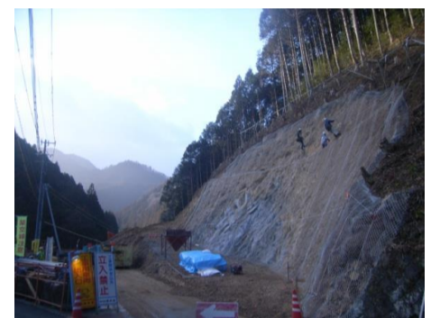
施工箇所(終点側から撮影)
