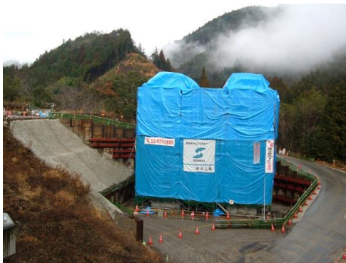
P2橋脚施工箇所(南→北)
