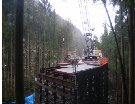
仮橋施工箇所(トンネル坑口側から撮影)
