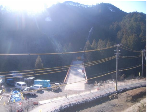
仮橋施工箇所(起点側から撮影)
