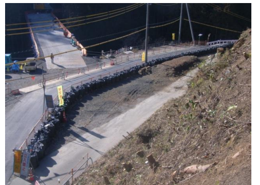
施工箇所(起点側から撮影)
