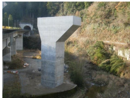
施工箇所全景(終点より)
