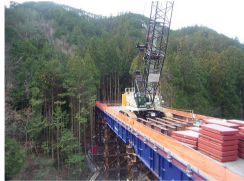
仮橋施工箇所(起点側から撮影)
