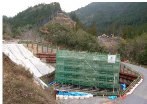
P2橋脚施工箇所(南→北)
