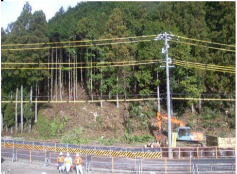
施工箇所(町道から撮影)
