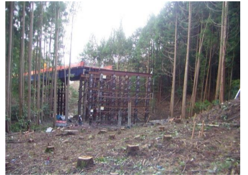
仮橋施工箇所(トンネル坑口側から撮影)
