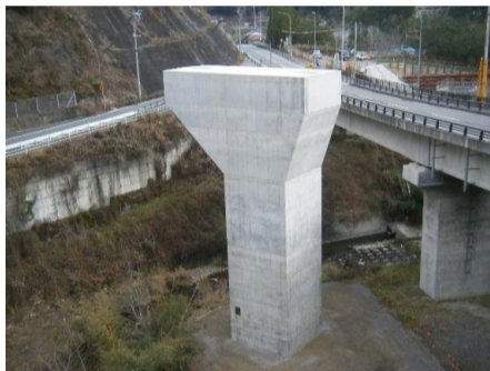
施工箇所全景(起点より)
