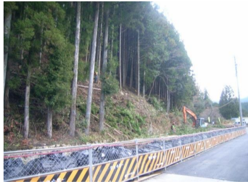
施工箇所(起点側から撮影)
