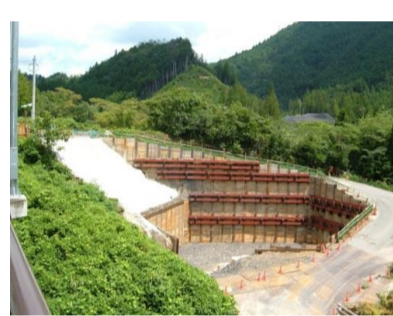
P2橋脚施工箇所(南→北)
