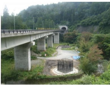
施工箇所全景
