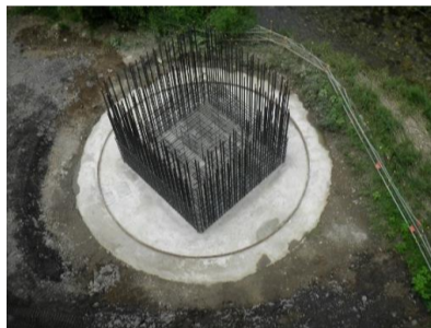
深礎工施工箇所
