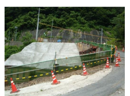
P2橋脚施工箇所(東→西)
