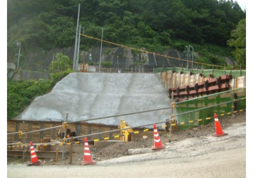
施工予定箇所写真(北から撮影)
