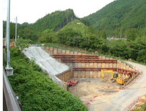
施工予定箇所写真(南から撮影)
