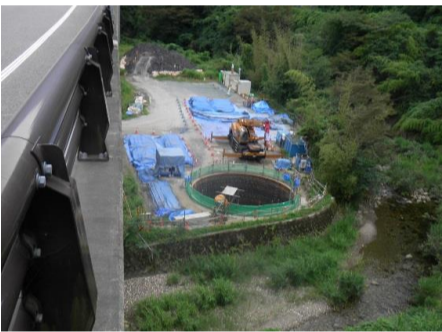
施工箇所全景
