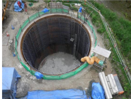
深礎工施工箇所
