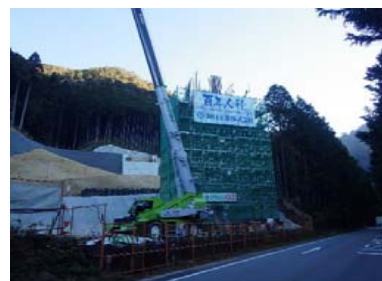
施工箇所(P4橋脚工区)
