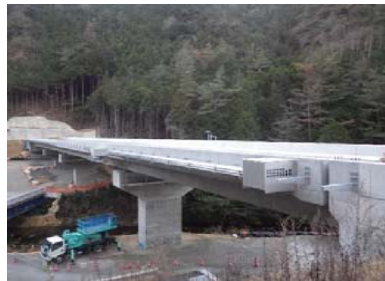
施工箇所(A2橋台より)
