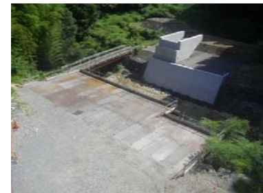
施工箇所(亀淵川工区)
