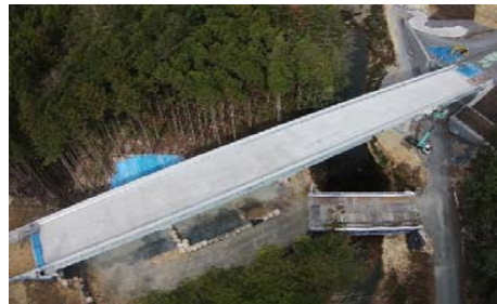
施工箇所(全景)
