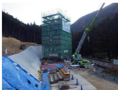
施工箇所(P4橋脚工区)
