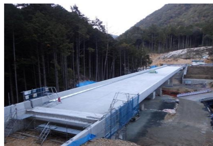
施工箇所(A1橋台より)
