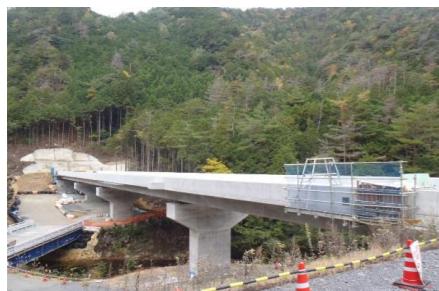
施工箇所(全景)
