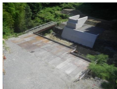
施工箇所(亀淵川工区)
