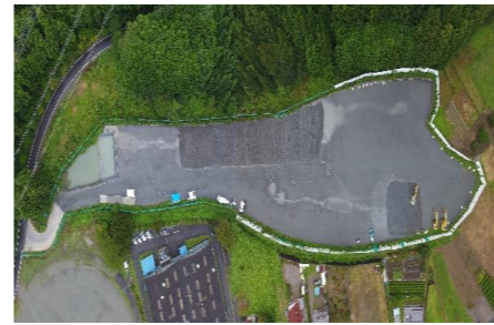
施工箇所(東栄地区)
