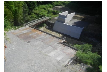
施工箇所(亀淵川工区)
