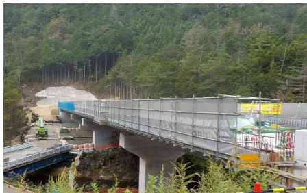
施工箇所(全景)
