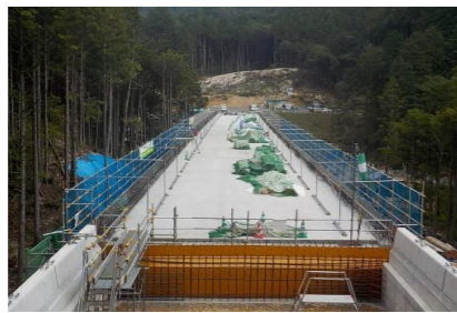
施工箇所(A1橋台より)
