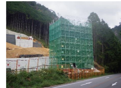
施工箇所(P4橋脚工区)
