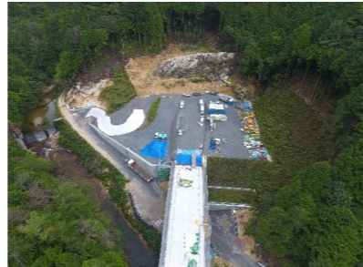
施工箇所(池場地区)
