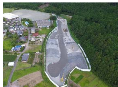
施工箇所(東栄地区)
