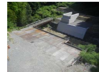
施工箇所(亀淵川工区)
