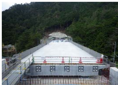
施工箇所(A2橋台より)
