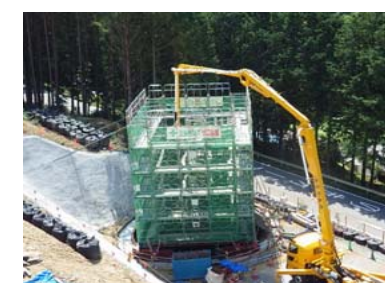
施工箇所(P4橋脚工区)
