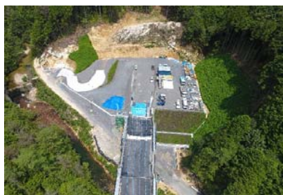
施工箇所(池場地区)
