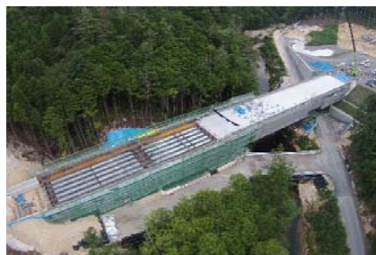
施工箇所(全景)
