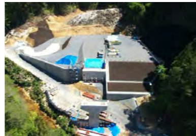
施工箇所(本線)
