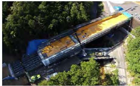
施工箇所(全景)
