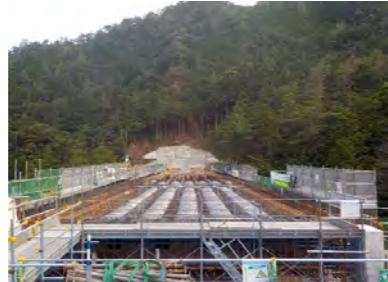
施工箇所(A2橋台より)
