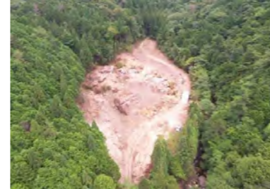
施工箇所(土砂仮置場)
