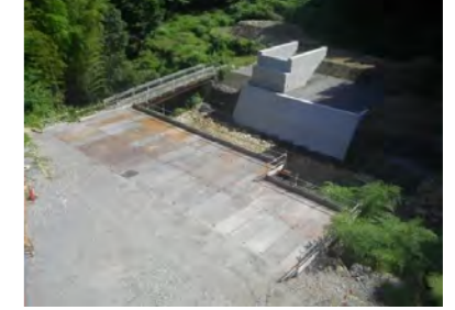
施工箇所(亀淵川工区)
