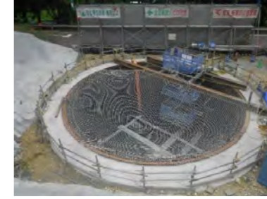
施工箇所(P4橋脚工区)
