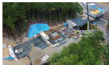
施工箇所(全景)
