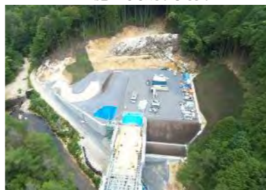
施工箇所(本線)
