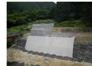
施工箇所(亀淵川工区)
