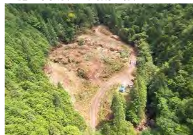
施工箇所(土砂仮置場)
