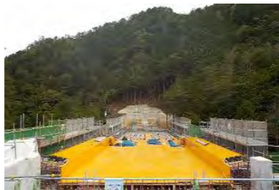
施工箇所(A2橋台より)
