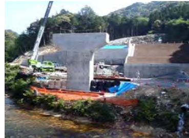
施工箇所(亀淵川 左岸)
