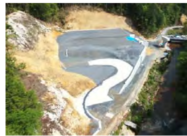
施工箇所(北から撮影)
