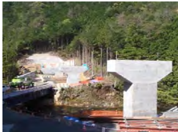
施工箇所(亀淵川 右岸)
