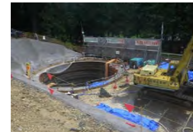
施工箇所(P4橋脚)
