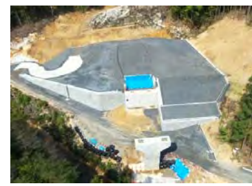
施工箇所(東から撮影)
