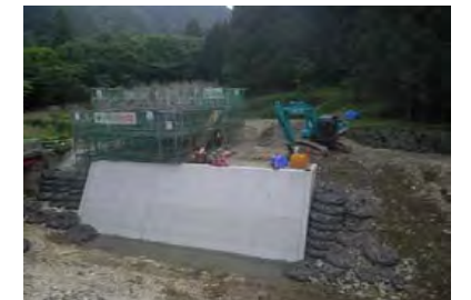
施工箇所(亀淵川周辺)
