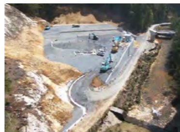
施工箇所(北から撮影)
