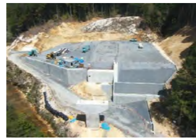
施工箇所(東から撮影)
