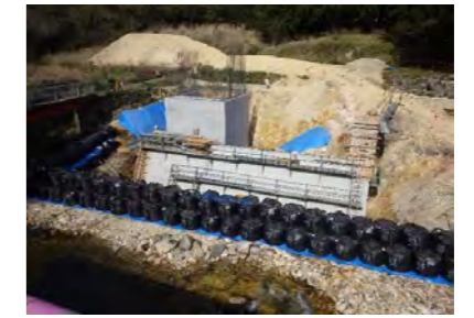
施工箇所(仮設構台、橋台)
