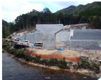
施工箇所(亀淵川 左岸)
