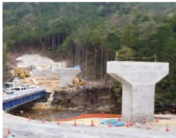
施工箇所(亀淵川 右岸)
