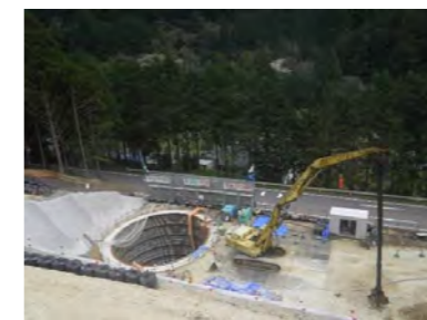
施工箇所(P4橋脚)
