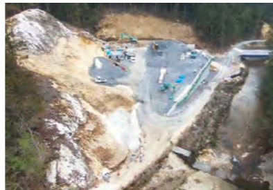
施工箇所(北から撮影)
