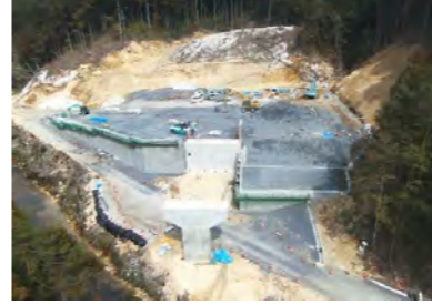
施工箇所(東から撮影)
