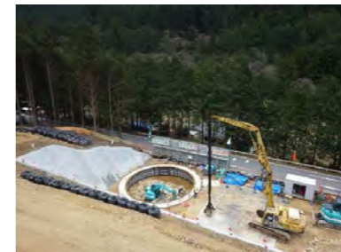
施工箇所(P4橋脚)
