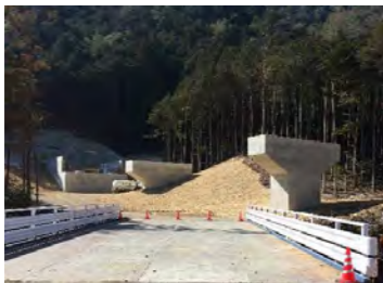
施工箇所(亀淵川 右岸)
