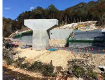
施工箇所(亀淵川 左岸)
