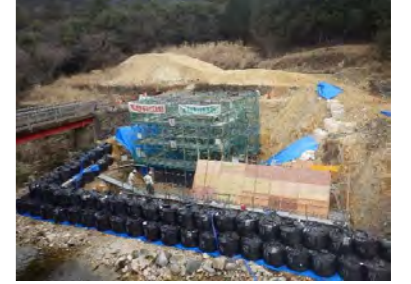
施工箇所(仮設構台、橋台)
