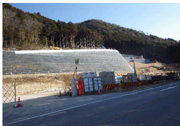
施工箇所(工事用道路部撮影)
