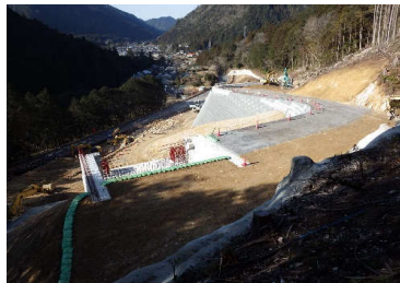
施工箇所(橋台部撮影)
