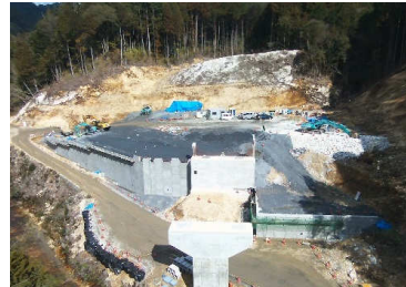
施工箇所(東から撮影)
