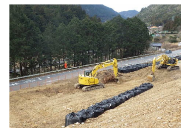
施工箇所(P4橋脚)
