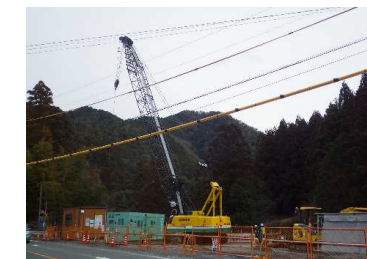
施工箇所(仮設構台、橋台)
