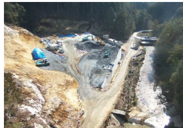
施工箇所(北から撮影)
