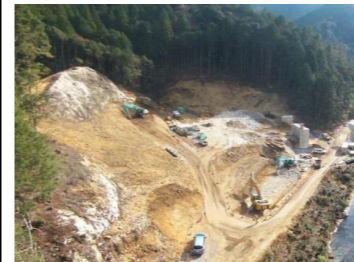
施工箇所(北から撮影)
