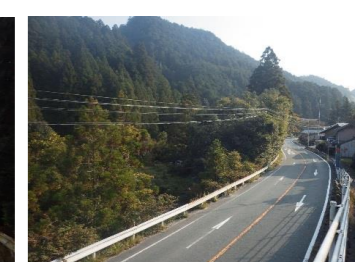
施工箇所(仮設構台、橋台)
