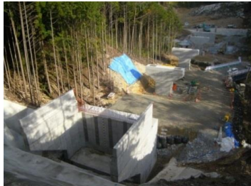
施工箇所(西から撮影)
