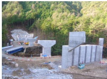
施工箇所(東から撮影)
