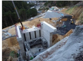
施工箇所(橋台部撮影)
