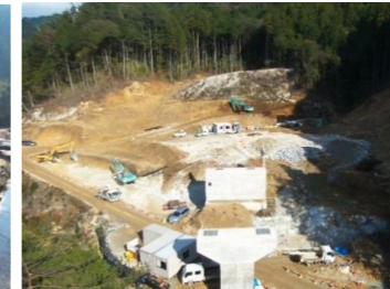
施工箇所(東から撮影)
