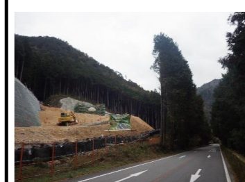
施工箇所(P4橋脚)
