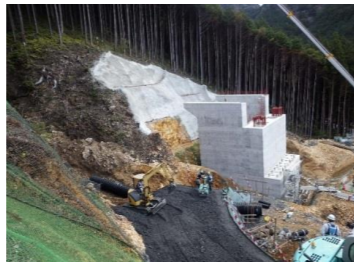
施工箇所(工事用道路部撮影)
