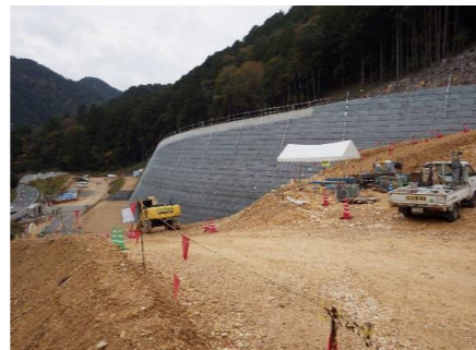
施工箇所(工事用道路部撮影)
