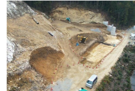
施工箇所(北から撮影)
