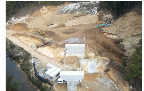
施工箇所(東から撮影)
