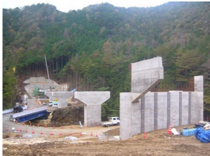
施工箇所(東から撮影)
