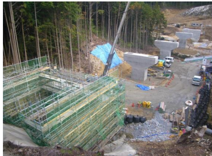
施工箇所(西から撮影)
