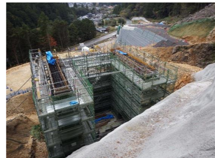
施工箇所(橋台部撮影)
